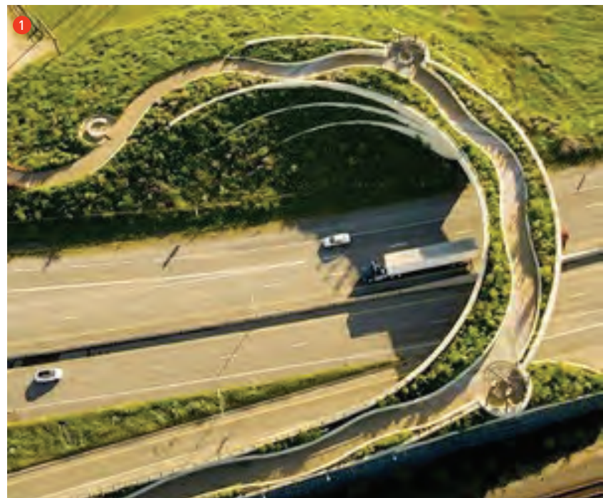
① Pont aménagé, Vancouver, Washington, États-Unis. Source: jonesandjones.com
