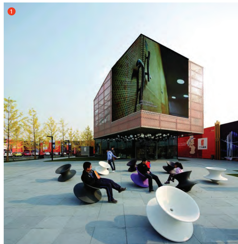
1 Bâtiment mixte, Jiangsu, Chine Source: archdaily.com
