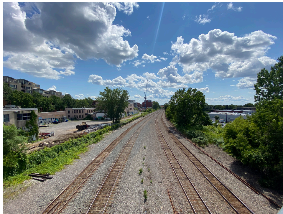
Figure 46 – Vue de la voie ferrée du CP en direction ouest
